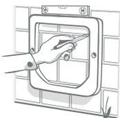
À présent, depuis l'extérieur de la maison, utilisez le trou percé comme référence et positionnez le cadre extérieur sur le mur. **Nous vous recommandons de positionner le cadre extérieur quelques millimètres plus bas qu'à l'intérieur pour permettre à la pluie à l'intérieur du tunnel de s'écouler à l'extérieur.**
